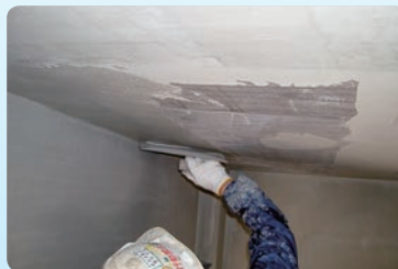
②ポリマーセメントモルタル塗布
