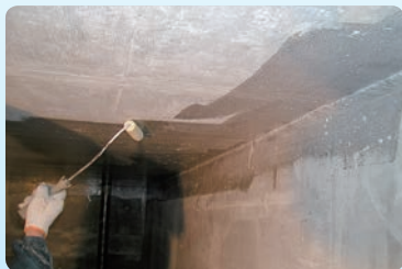
①プライマー処理
